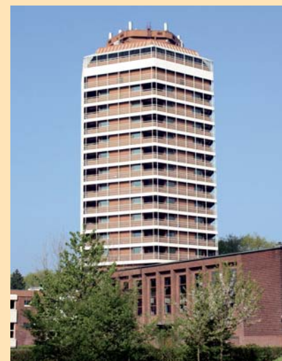
Überragend: Der „Bettenturm“ der Sportschule.
